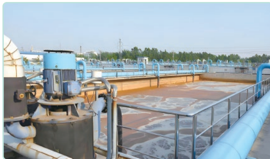
潍坊市污水厂污泥无害化处置项目
